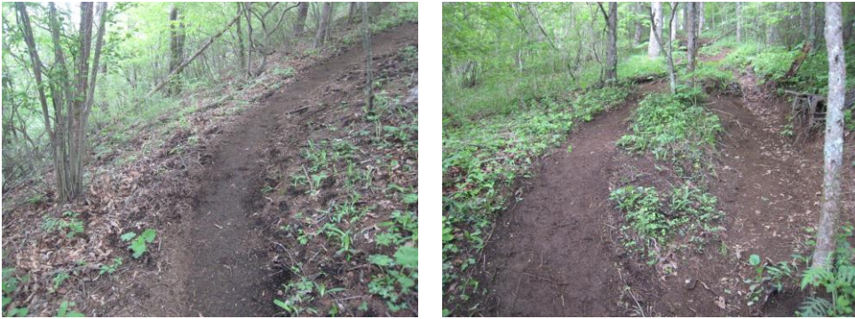
▲忍野高原で見られた路面の荒れの一部
